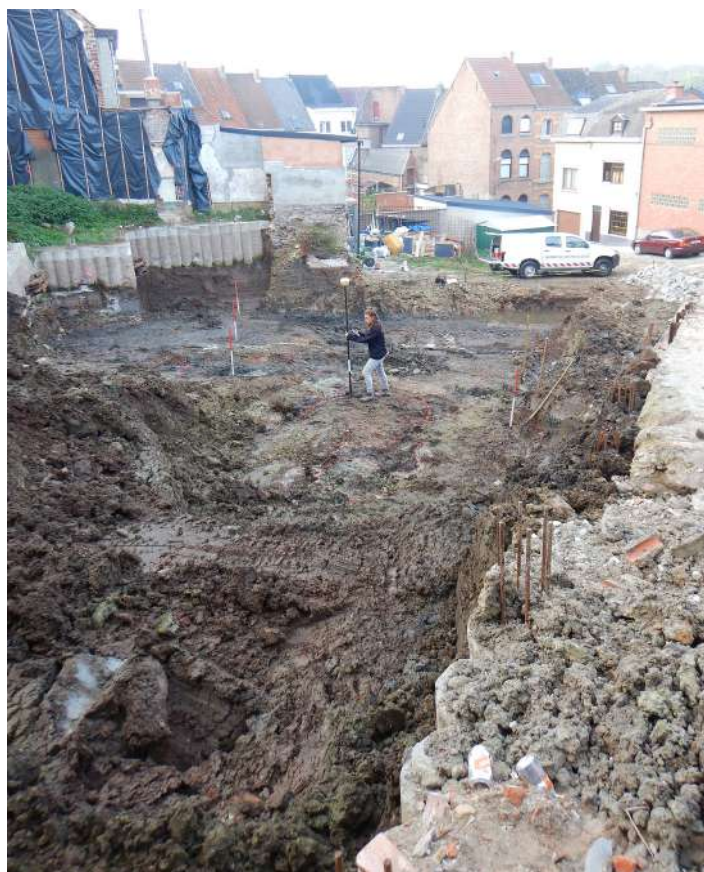
Figuur 8. Sfeerbeeld van een steeds complexer wordende logistieke situatie bij de aanleg van het derde en het vierde vlak.
