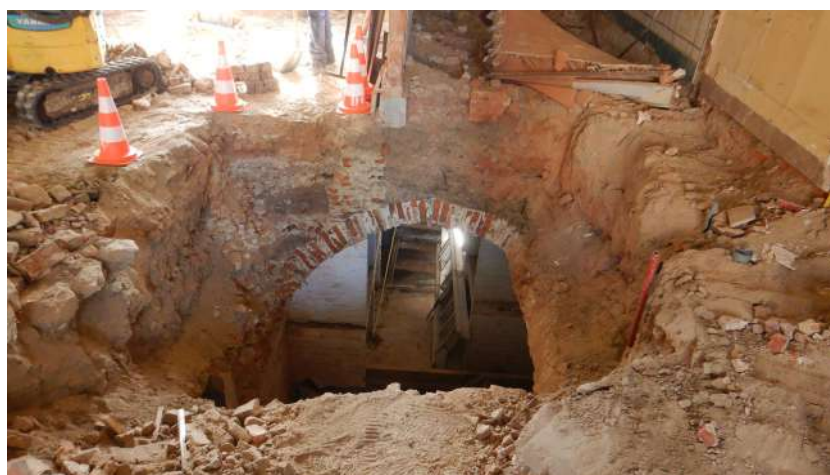
Figuur 4. Foto's bij de vaststelling van de reeds in uitvoering zijnde werken in het pand aan de Markt.
