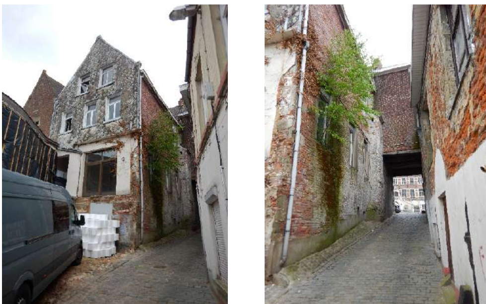
Figuur 32. Zicht op de achter- en zijgevel van het huis aan de Markt 49 (@Hembyse).
