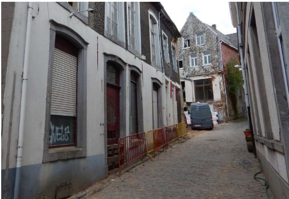
Figuur 6. Zicht op de enige toegang tot het onderzoeksgebied, slechts moeizaam bereikbaar voor machines (graafmachine, tractoren).
