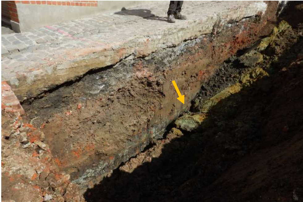
Figuur 19. Het verval (gele pijl) in de top van het tertiair zoals vastgesteld tijdens de begeleiding van de aanleg sleuf van de palenwand.
