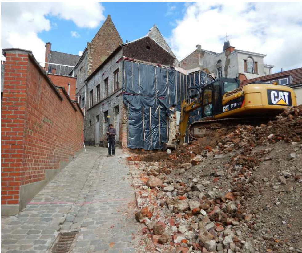
Figuur 7. Zicht op de logistieke moeilijkheden bij het afgraven van grond, richting Brandstraat. Bemerk het hoogteverschil op basis van de omliggende daken.
